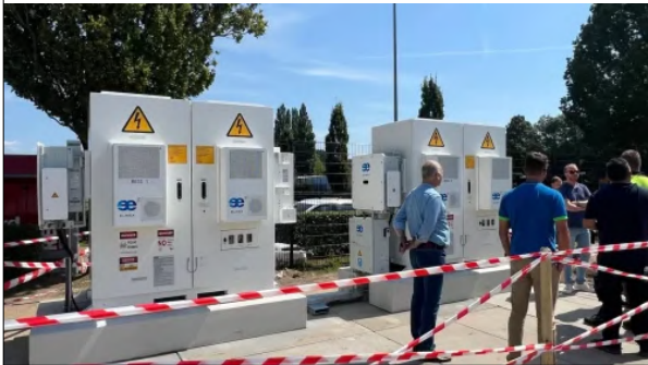
Een groot batterijen pakket, gekoppeld aan 114 zonnepanelen
